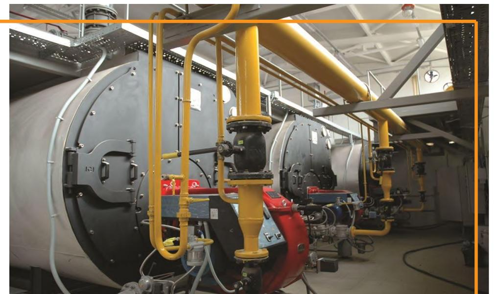
Автономная газовая котельная с двумя водогрейными котлами
